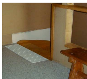
Changement de texture au sol
